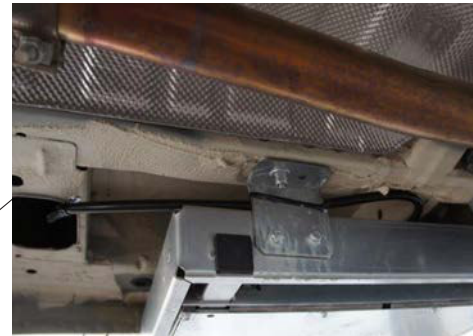
Kabel in der B-Säule hochbringen
