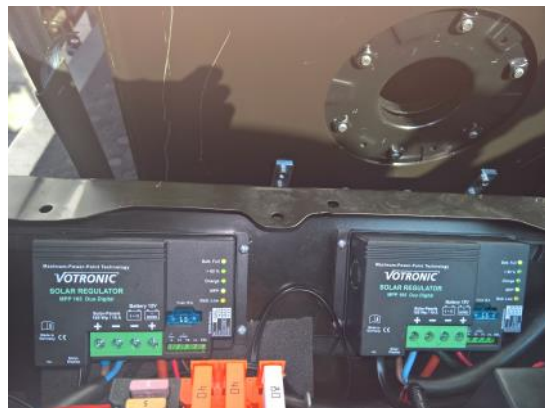
2 x Solarladeregler Einbau unter dem Beifahrersitz Position hinten
