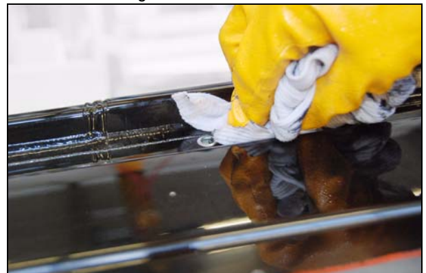
Abb.: überschüssiges Sika entfernen
