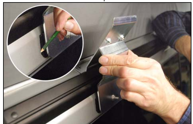
Abb.: Klebefläche für die Stützplatte markieren
